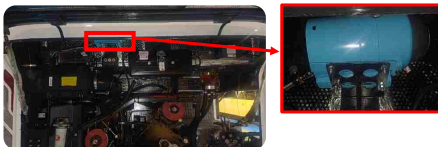
تصویر ۳۴ : موقعیت کپسول اطفاء حریق و کپسول اطفاء حریق
